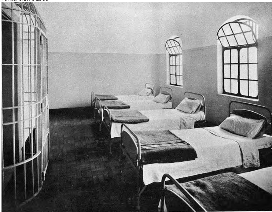
Detalhe da porta gradeada disposta em semicírculo, de forma a permitir ao guarda, sem se expor, observar todo o interior do dormitório.
